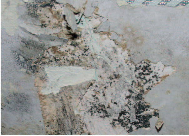
Schimmelpilzbefall hinter einer Tapete
